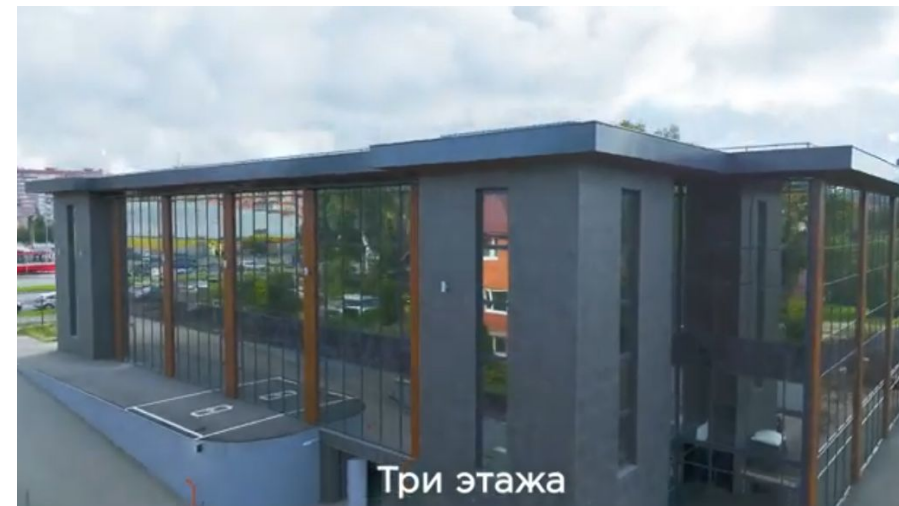
Помещение готово под отделку
